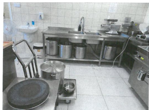
Wyposażenie kuchni – urządzenia do obróbki
