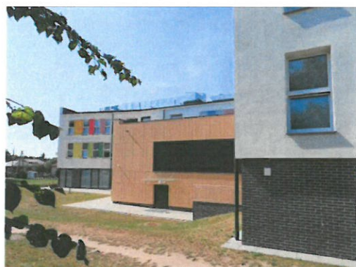
Elewacja boczna budynku przedszkola z salą widowiskową – część dobudowana
