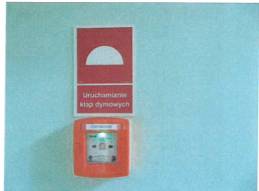
Klatka schodowa z systemem oddymiania
