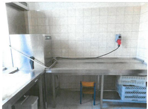
Zmywarka kapturowa w pomieszczeniu zmywalni
