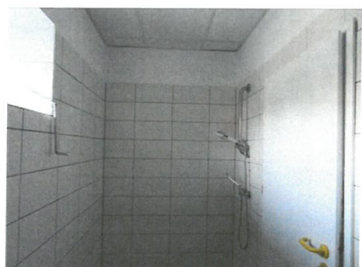
Łazienka dla personelu dostosowana do potrzeb osób z niepełnosprawnościami
