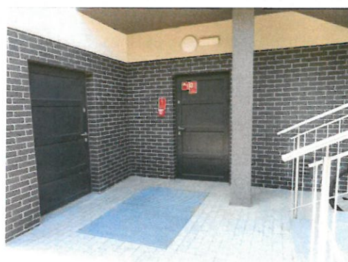
Wejście gospodarcze do budynku przedszkola
