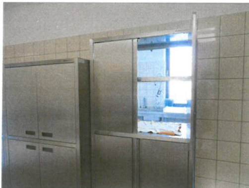
Szafy magazynowe w tym szafa przelotowa w pomieszczeniu wydawalni posiłków
