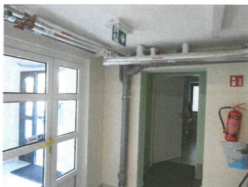
Wejście gospodarcze, instalacje
