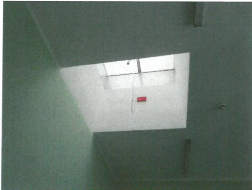
Klatka schodowa z systemem oddymiania
