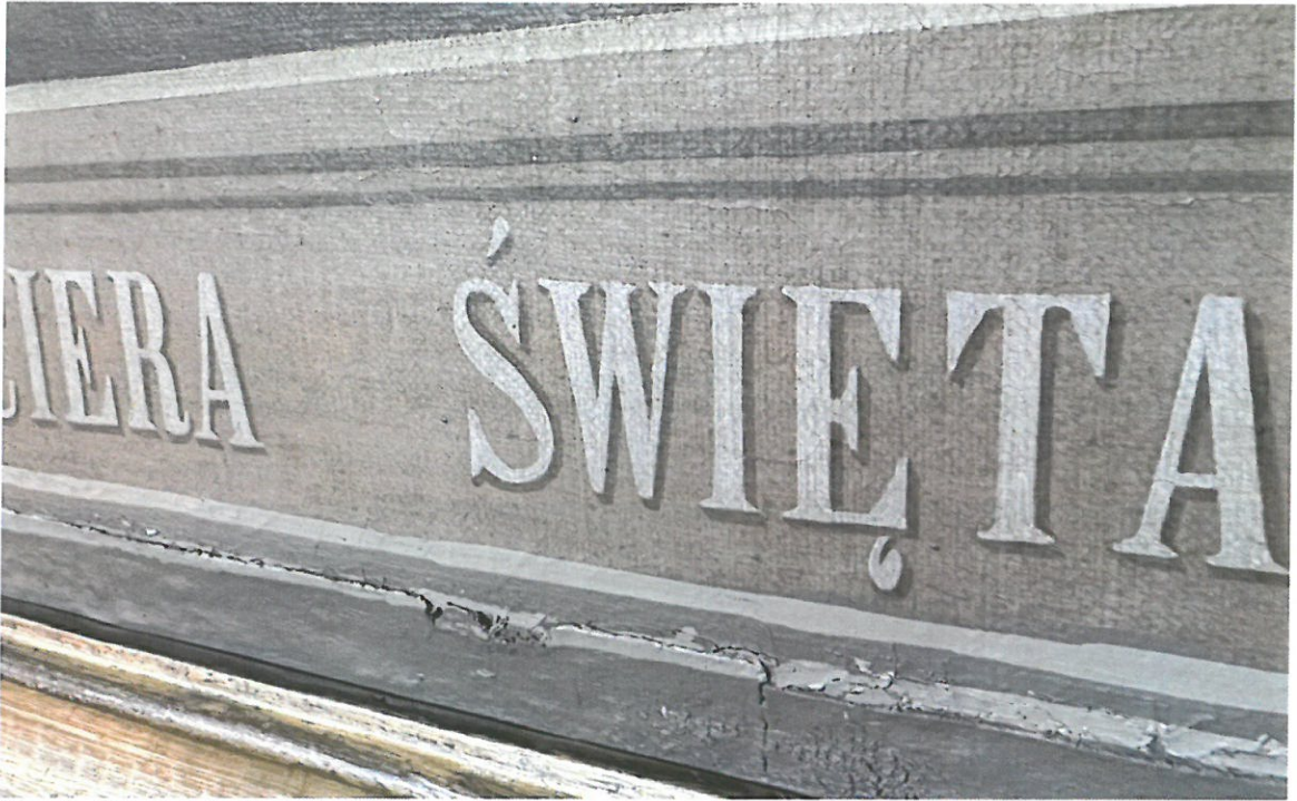
Stacja VI, fot. 2. Detal. Widoczna dawna reperacja dolnej krawędzi obrazu, szare przemalowanie na doklejonej taśmie, spękania na złączeniach oraz zabrudzenia powierzchni.
