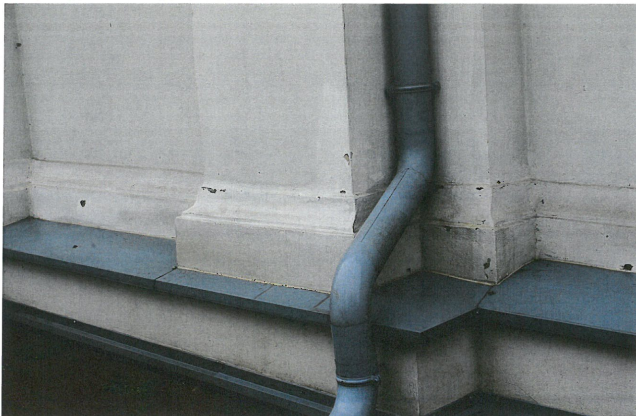
ZDJ. 2, 3 WASILKÓW, CERKIEW PARAFIALNA P.W. ŚWW APOSTOŁÓW PIOTRA I PAWŁA. SPĘKANIA I ODSPOJENIA WARSTW POWIERZCHNIOWYCH
