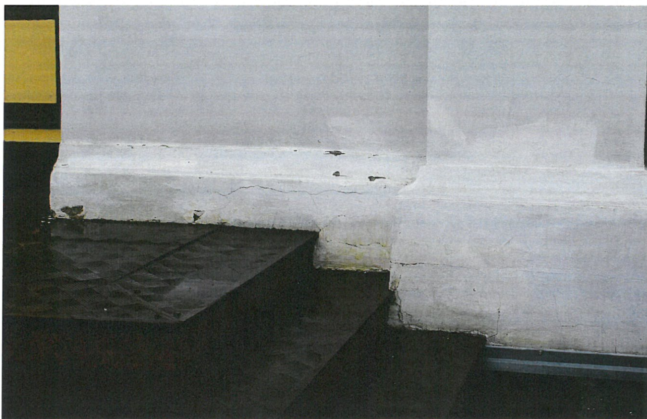
ZDJ. 2, 3 WASILKÓW, CERKIEW PARAFIALNA P.W. ŚWW APOSTOŁÓW PIOTRA I PAWŁA. SPĘKANIA I ODSPOJENIA WARSTW POWIERZCHNIOWYCH
